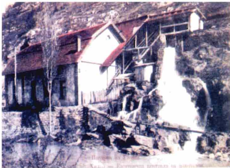
Прва хидроелектрана у Србији на Бетињи, рађена по пројекту Ђорђа Станојевића. Фотографија Ђ. С.
