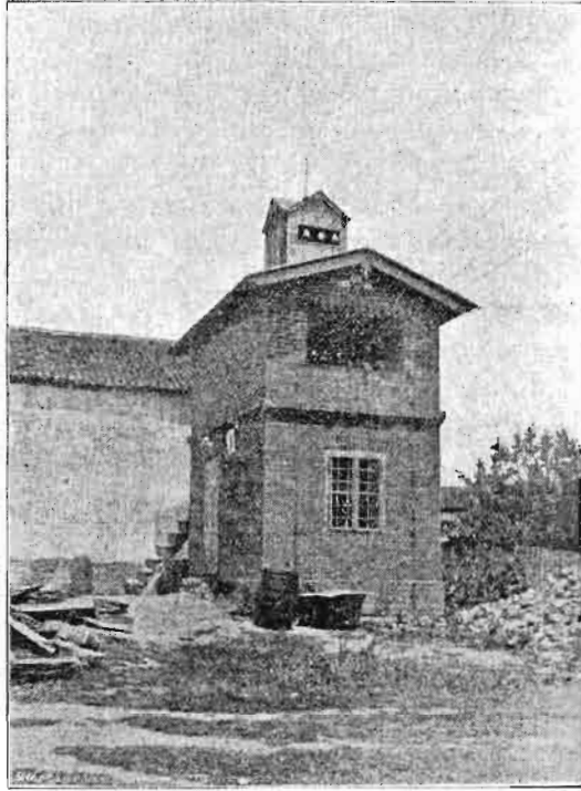
Електрично осветљење у Лесковцу. Сл. бр. 7. „Централа у Лесковцу“.
